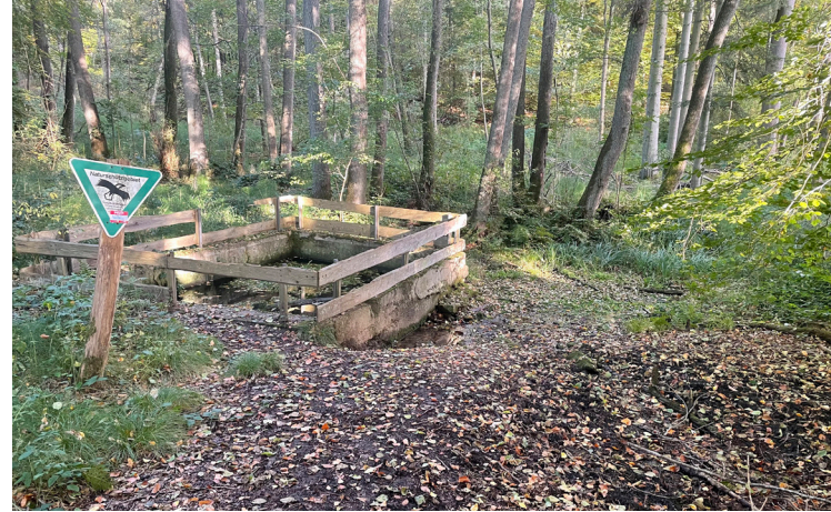
7 Quellen vor Renaturierung
